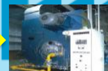
既設ボイラー
