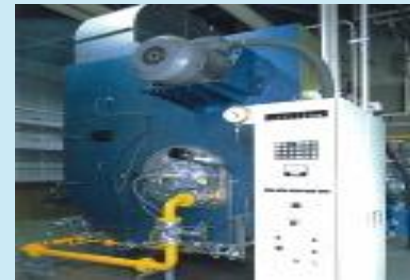
〈高性能ボイラー〉
