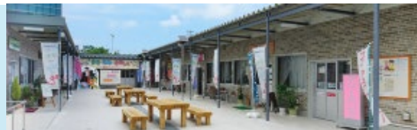
中小機構が設置した仮設施設
