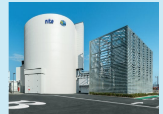
NLABの多目的実験棟
