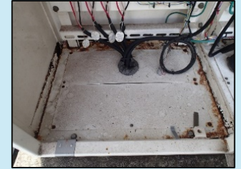
空調設備の腐食 バイオテクノロジーセンター（木更津市）20年以上経過
