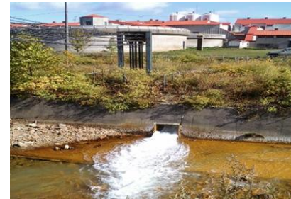
中和処理を行う坑廃水処理施設における省エネルギー設備改修等を実施
