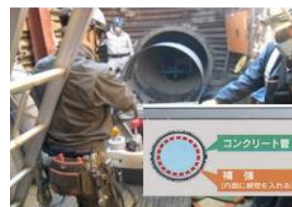
例：管路の耐震補強
