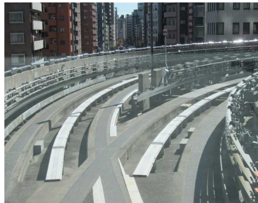
図 3-21 分岐器部電線路設備
