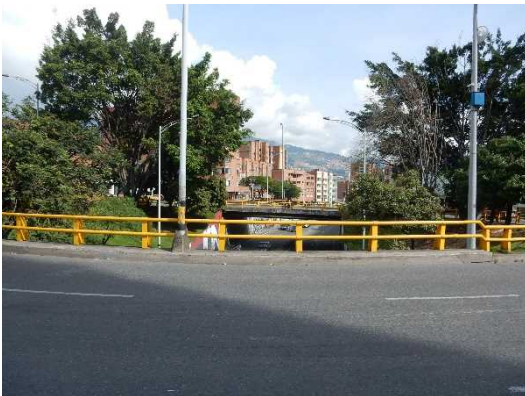
写真－11 Tranvia との交差部
