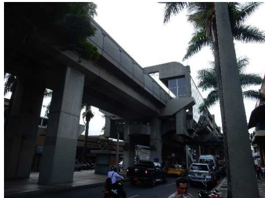
写真－16 メトロ A 線 Alpujarra 駅
