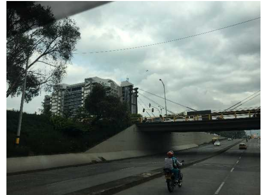
写真－14 ルート上にある立体交差（斜張橋）
