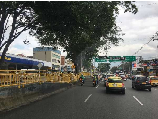
写真－13 自転車道の中央分離帯
