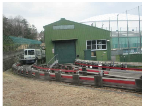
図 3-34 検査ピット(西武山口線)
