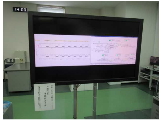
Figura 3-29 Monitor de depósito de trenes
