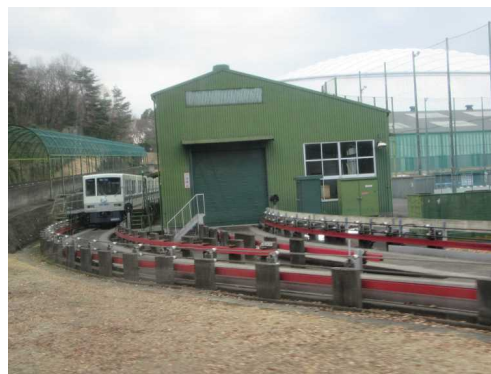
Figura 3-34 Puesto de inspección (Línea Seibu Yamaguchi)
