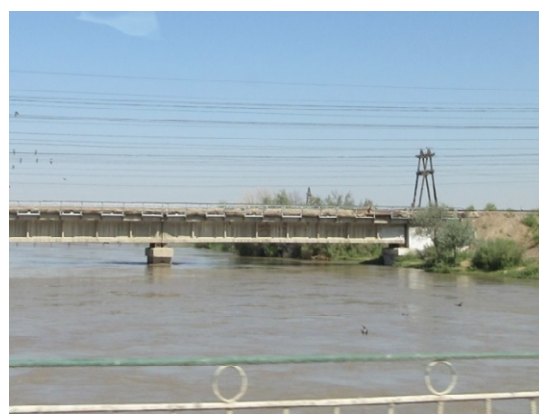
Предварительно напряженная железобетонная ферма
