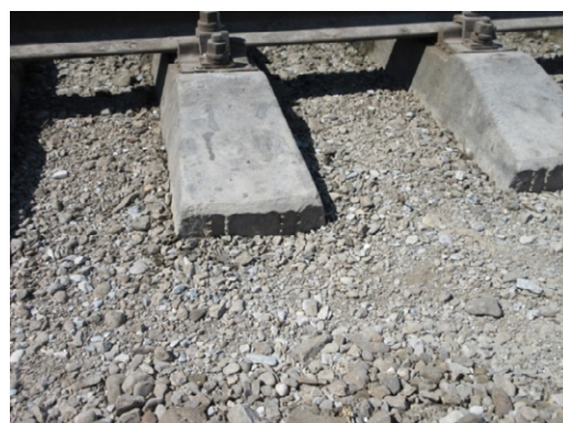
Рисунок 3-11 Отсутствие балласта
