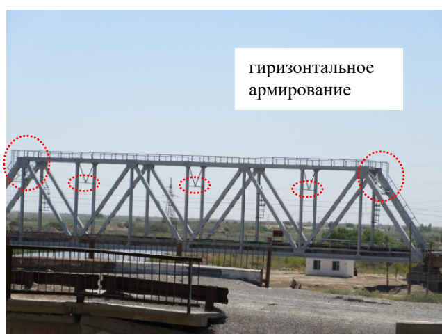
Рисунок 3-17 Горизонтальный арматурный стержень для металлического моста со сквозными балочными фермами
