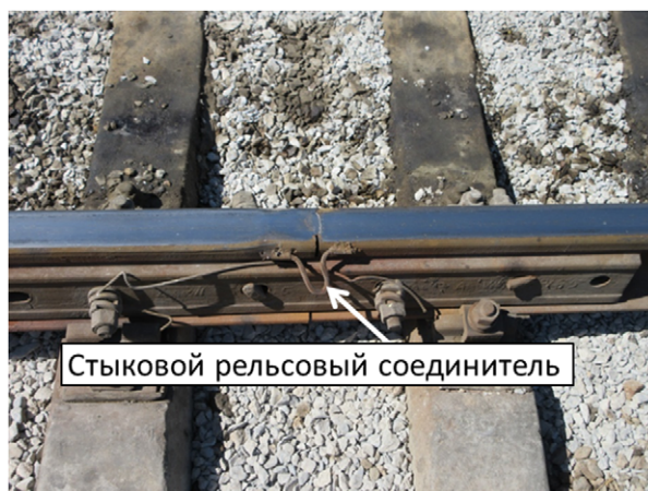
Рисунок 4-19 Действующие Стыковые Соединители в Туркменистане
