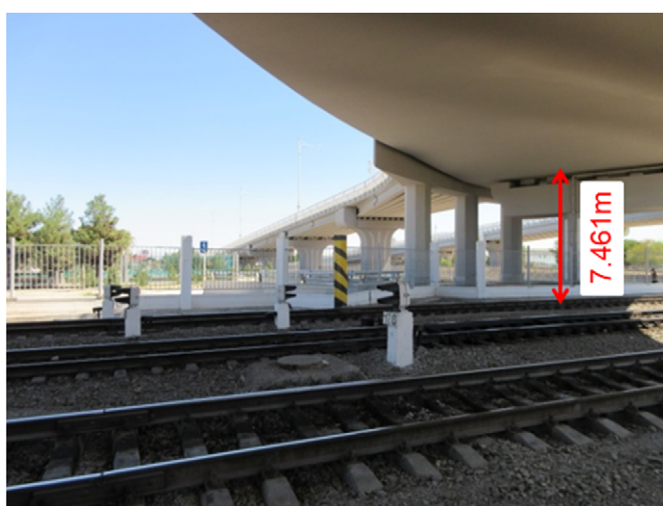
Рисунок 3-20 Нижние габариты надземных мостов вокруг станции Ашхабад
