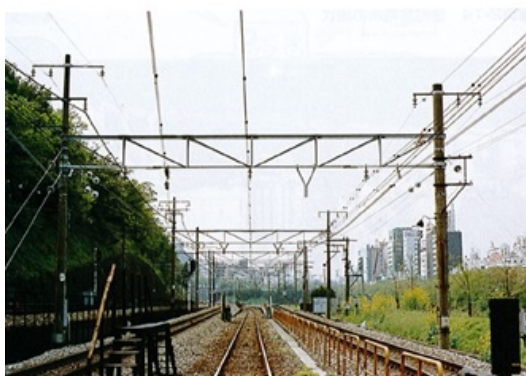
Рисунок 4-31 Подвесная Контактная Линия
