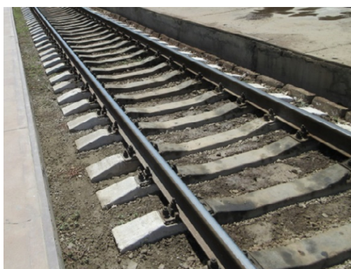
Рисунок 3-11 Отсутствие балласта
