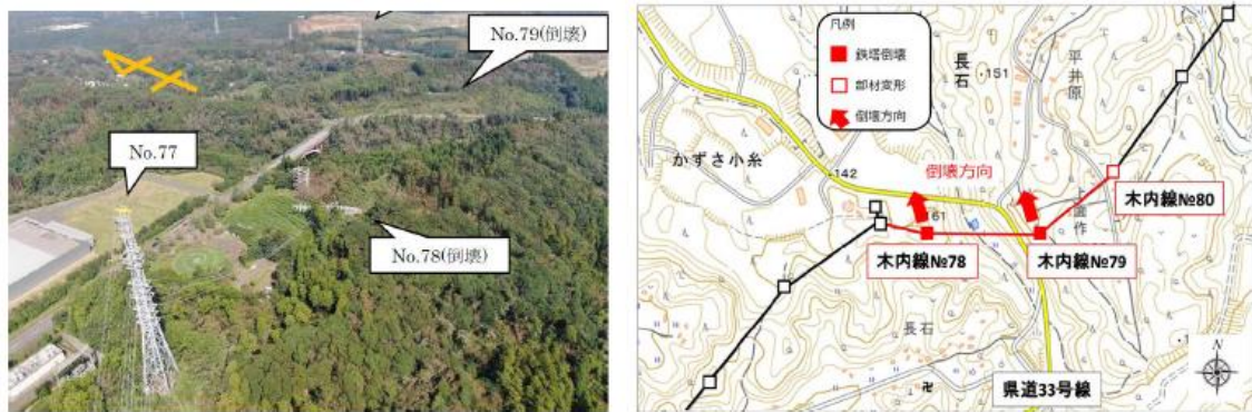
図 3-7 倒壊した鉄塔の位置と倒壊方向 20
