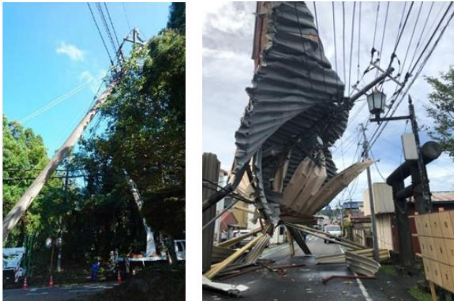
図 3-10 倒木・飛来物による電柱損壊現場の様子 20
