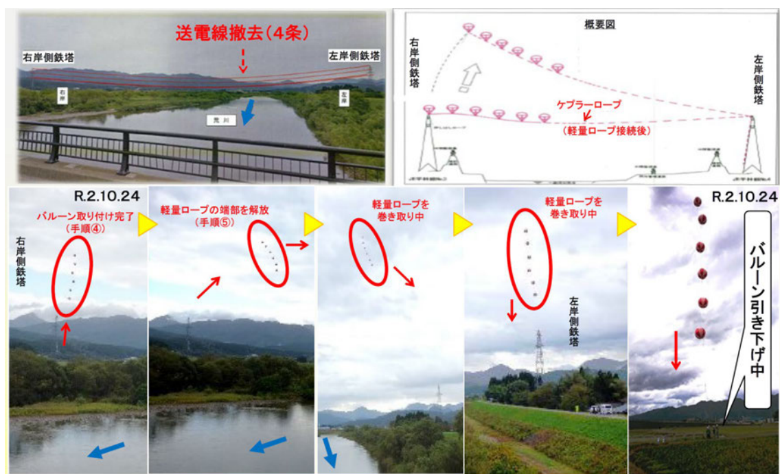
図 2-1 バルーンによる送電線撤去工法 5
