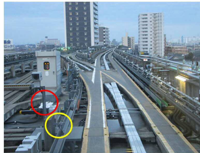
分岐器の構造(転てつ機(赤)と可動案内板(黄))
