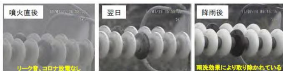
図 2.9 ITV カメラで確認された雨洗効果の状況 4)
