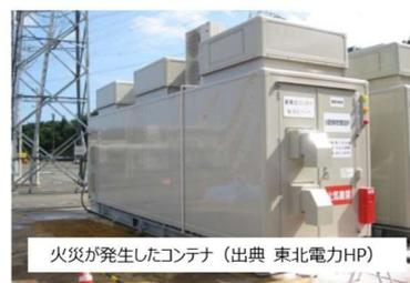
図 3.2 国内で発生した BESS の事故事例
