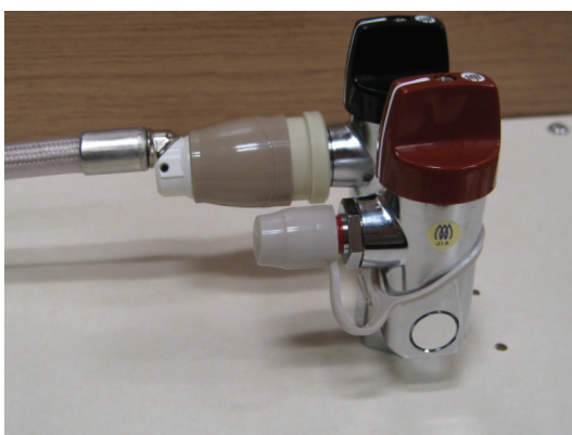
ホースエンド口に装着したガス栓キャップ
