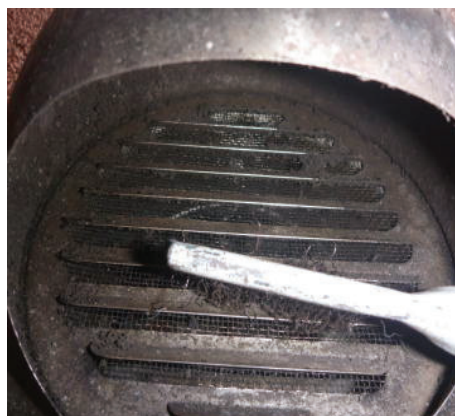
給気口の清掃の様子
