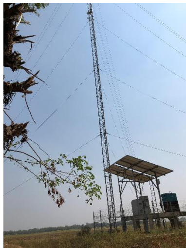
図 16 隣村の通信タワーとディーゼル発電機
