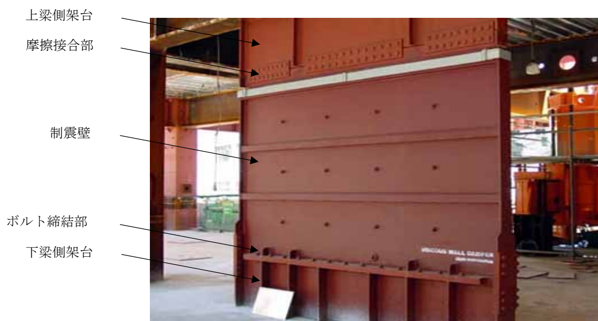
参考図 6. 壁型粘性ダンパの施工例
