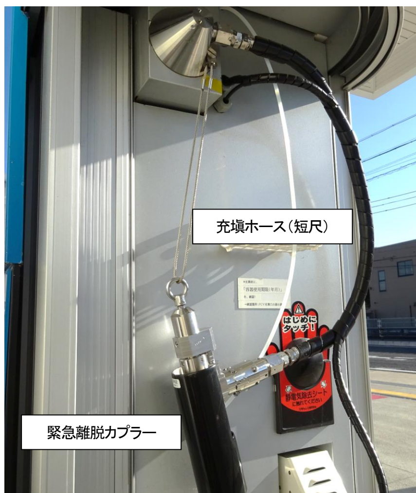
図2 ディスペンサーの短尺充填ホース (事故後に撮影)
