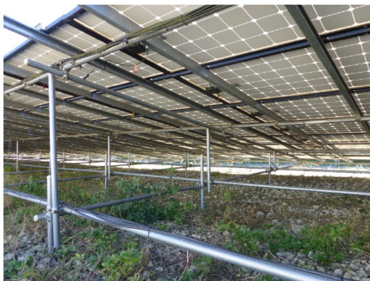
写真 3 単管架台の例（当社撮影）
