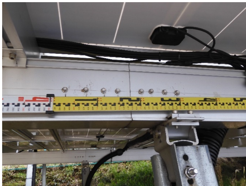
写真 12 横梁の長さと継手（現地調査）
