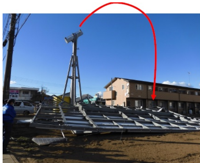
写真 2 損害状況（現地にて撮影：構造耐力評価機構）
