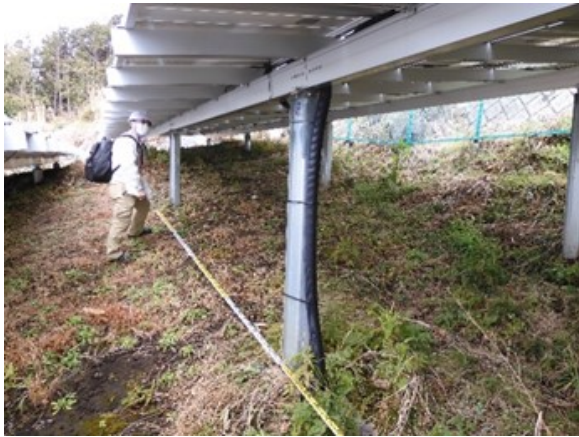
写真 11 杭長手方向の間隔（現地調査）
