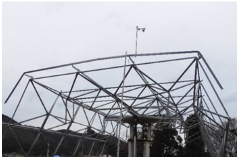
写真 8 損壊した施設の解体中の状況 (現地調査)
