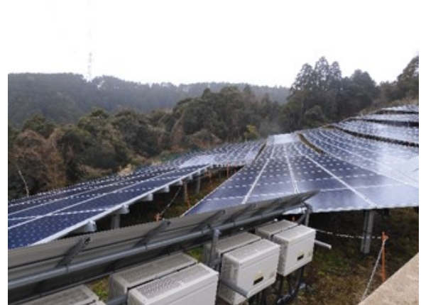
写真 13 アレイ面の傾斜角度 写真左は南北傾斜、写真右は東西傾斜（現地調査）
