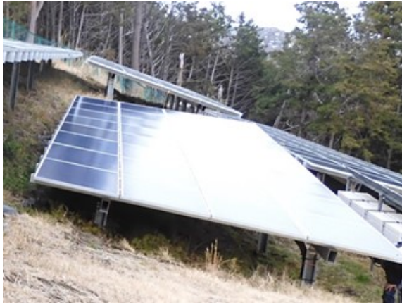
写真 13 アレイ面の傾斜角度 写真左は南北傾斜、写真右は東西傾斜（現地調査）
