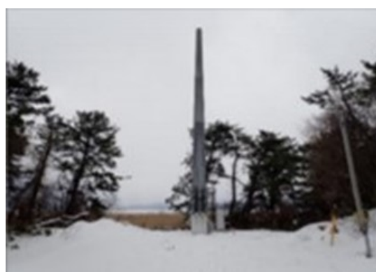
＜小型風力発電設備の事故例＞
