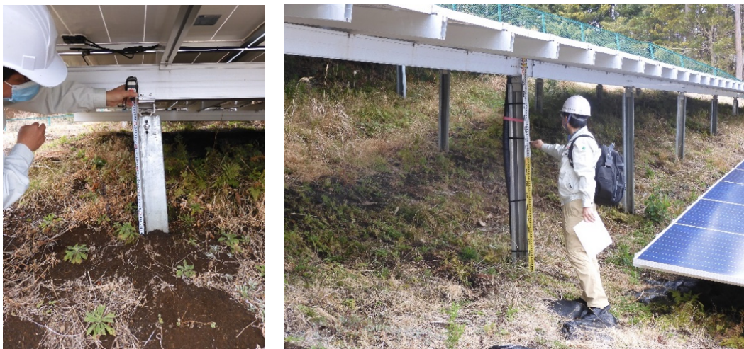
写真 10 現地調査 杭突き出し高さ (現地調査)
