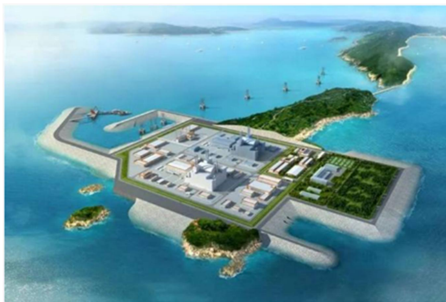
図 1.1.5-2 福建省霞浦原子力発電所サイト (高速炉実証炉 CFR-600) (出典：CNNP 社)
