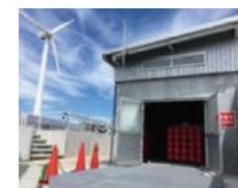
高圧水素設備
