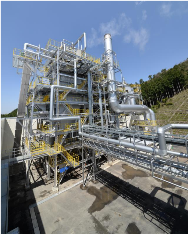
写真：バイオマス発電所
