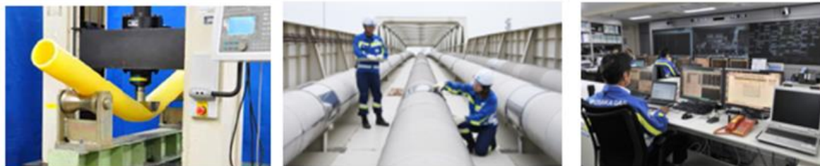
図表3-4：パイプラインにおける漏洩対策例（ポリエチレン管の採用、定期点検、中央保安司令部での24時間監視）
