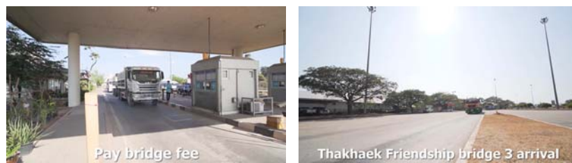
図 22 第 3 メコン友好橋・国道 13 号線
