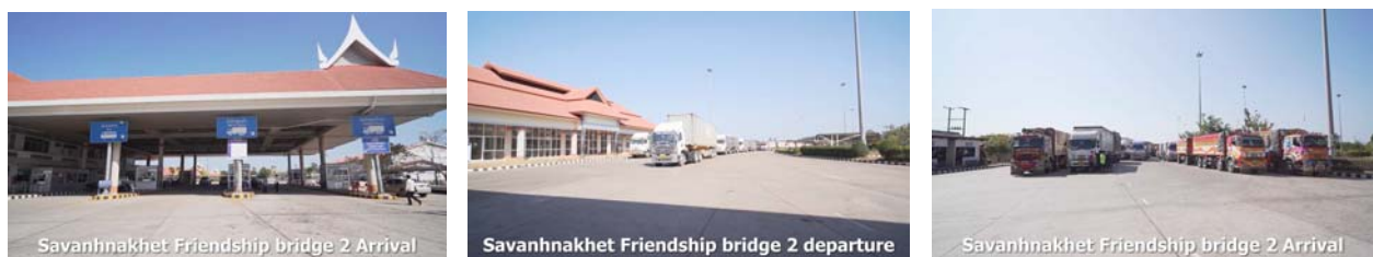
図 24 第 2 メコン友好橋
