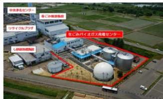
生ごみバイオガス発電センター
