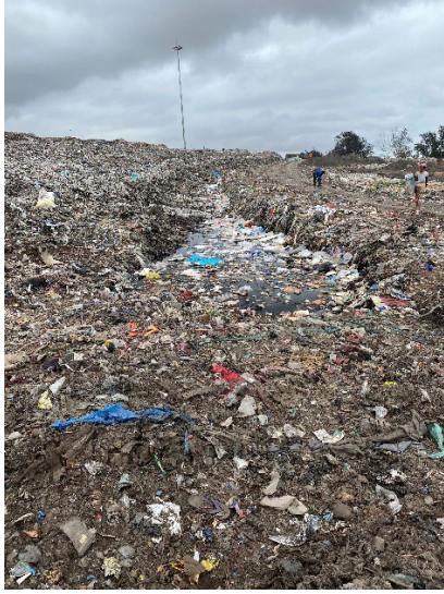
図7 ごみと浸出液で満たされた人工の溝
