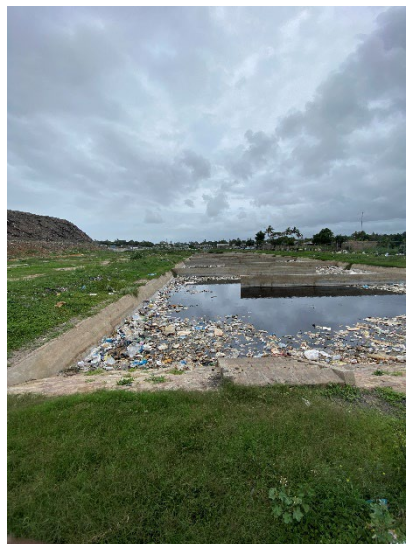
図 18 浸出水の収集および貯蔵タンクⅡ
