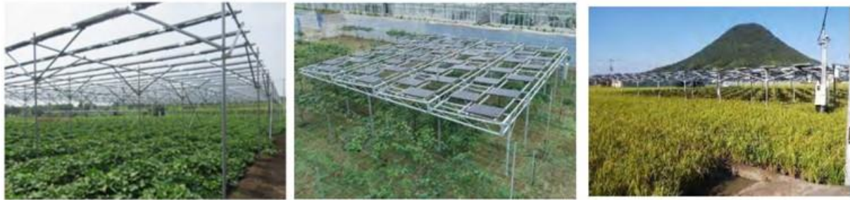
写真 2-6 営農型太陽電池発電設備の設置例
