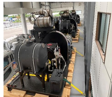
超高圧水ポンプ
