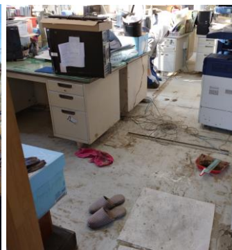
被災後の事務所
