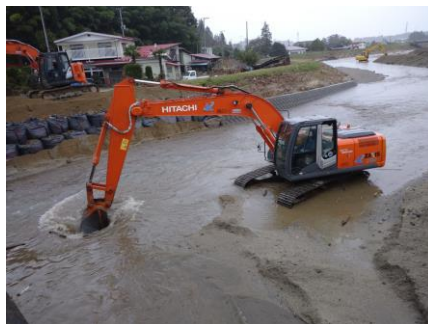
河道内の土砂撤去の様子
