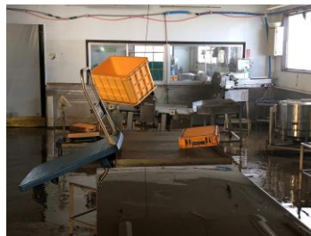
被災した本社工場
