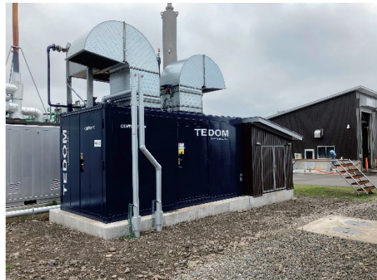
図2 発電機3(TEDOM製100kW出力)とブラックアウトスタートに利用するガス混合ユニット
