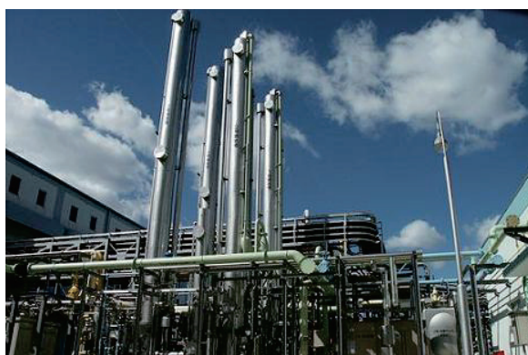
写真 1 こうべバイオガス精製設備 1)
