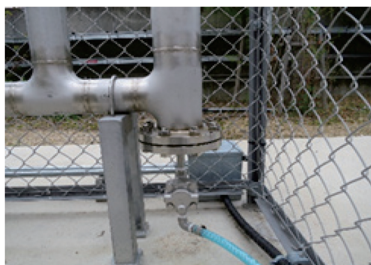
写真3 燃料配管端のドレン水排出
