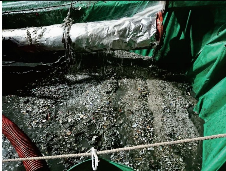
写真2 配管内に溜まっていた砂やガレキ
