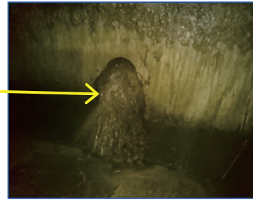
写真3 入口ホッパー内部(閉塞状況)
