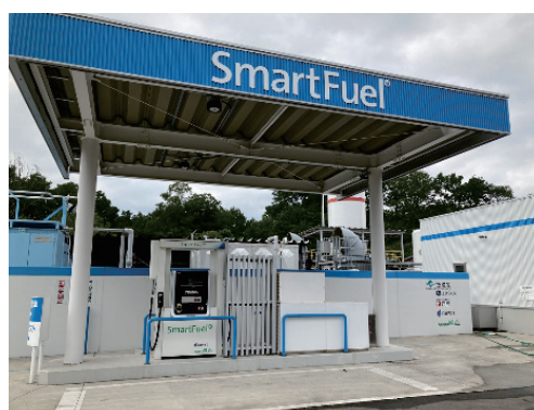
図6 水素ステーション
