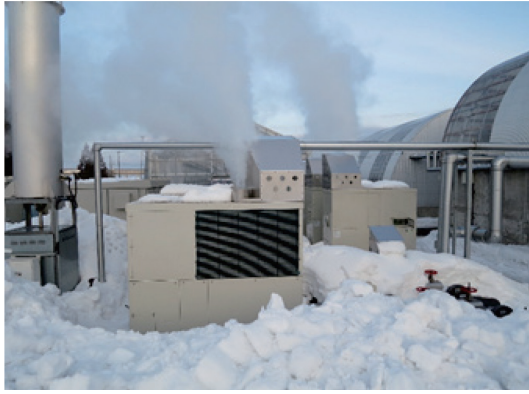
写真5 配管内部で凍結、排気閉塞
