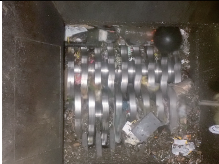
写真1 破碎破袋装置 内部（二軸せん断機）
