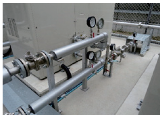
写真4 燃料配管の母管のドレン水排出
