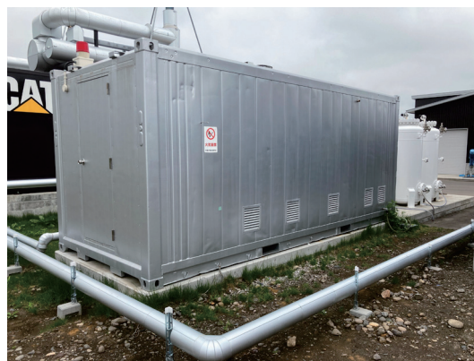
図 4 バイオガス精製装置
