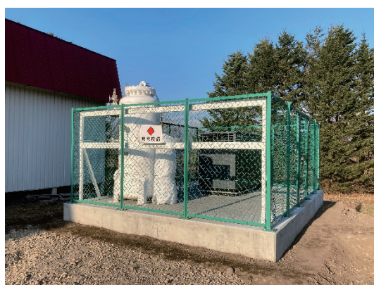
図5 美蔓福祉館発電機写真
