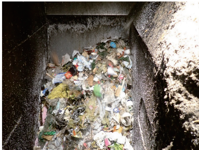
写真2 中間貯槽 内部
