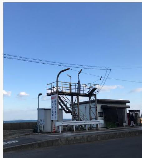
トラックスケール前の検品所。サンプル採取が架台から行えるだけでなく、チップ車上での作業時に安全帯を掛けられる設備も設置されている。
