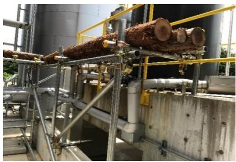
図-4-1-4.降雪による配管損傷防止策
