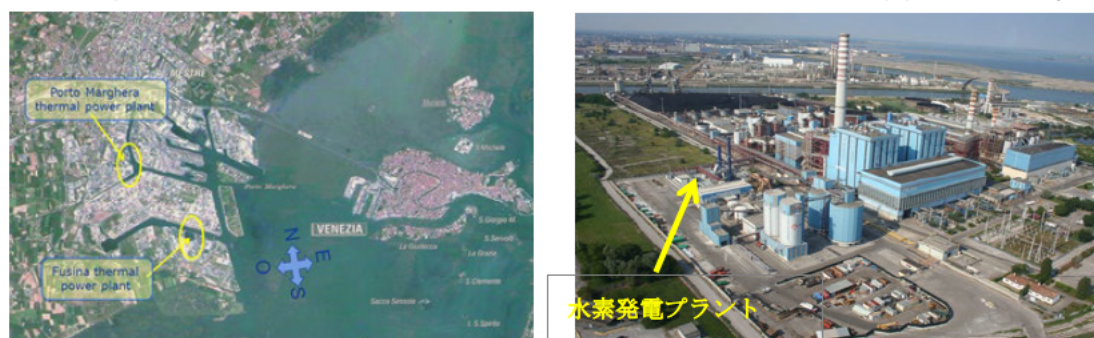
図 2.5 (左) Fusina 発電所の場所 (右) Fusina 発電所全景 7)
