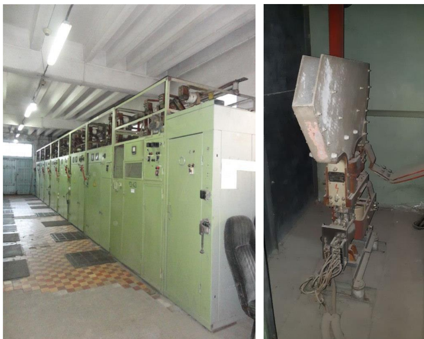
図 4-15：直流遮断器（ソ連製）
