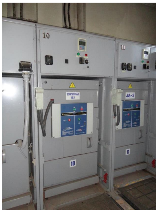
図 4-16：12 [kV] 交流遮断器（中国製）
