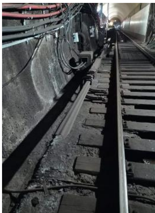
図 4-18：サードレールと絶縁装置の現場状況
