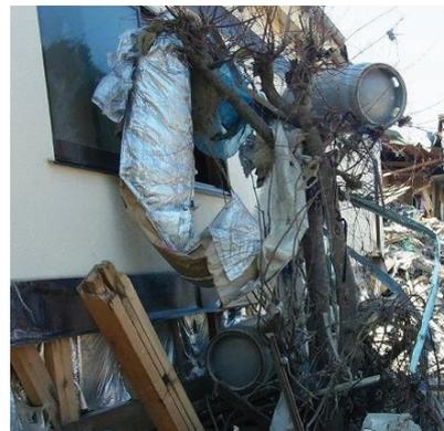
津波が押し寄せた地域では、比較的低い津波（1m程度）であっても、消費先に設置されている容器が足元をさらわれ、容器が転倒し、供給設備が損傷する被害が発生した。
