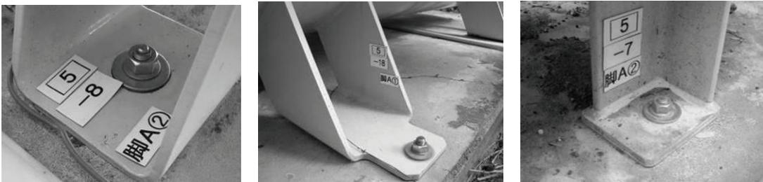
図1.24 バルク貯槽の固定例
