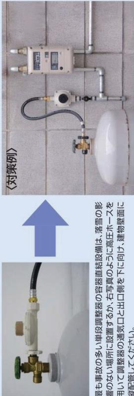
最も事故の多い単段調整器の容器直結設備は、降雪の影響のない場所に設置するか、写真真のように高圧ホースを用いて調整器の通気口と出口側を下に向け、建物壁面に縦配置してください。
