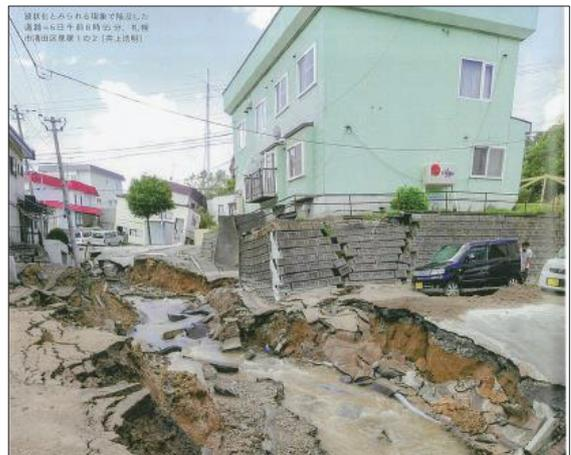
液状化により地盤沈下が発生
