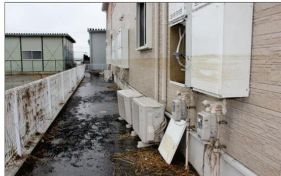
給湯器の高さまで水没した形跡が見られる
