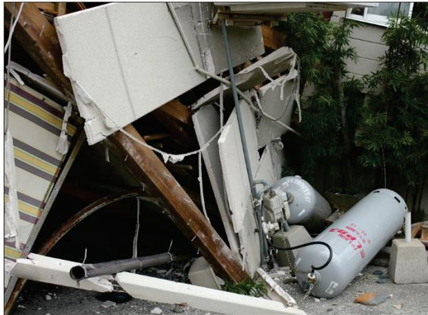
地震で倒壊し家屋で被害のあった LP ガス供給設備【プロパン・ブタンニュース提供】
