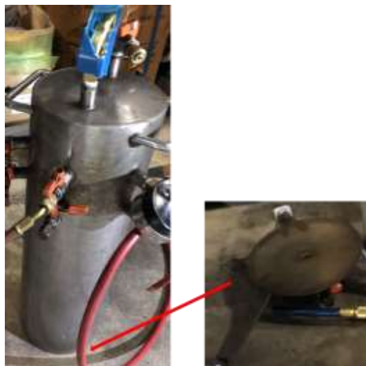
図 1 事故時の油分離器(左側: 飛翔した上部、右側: 溶接部が破断した底部)
