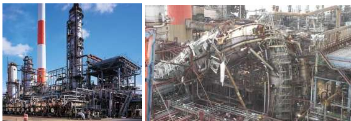
図 1 倒壊した主蒸留塔 (左:火災事故前、右:火災事故後)
