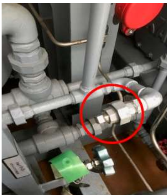
図 4 プラグによる閉止
