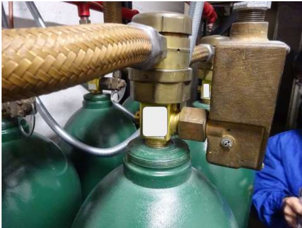
図 5 コントロールヘッド(ソレノイド式)と容器弁(附属品)
