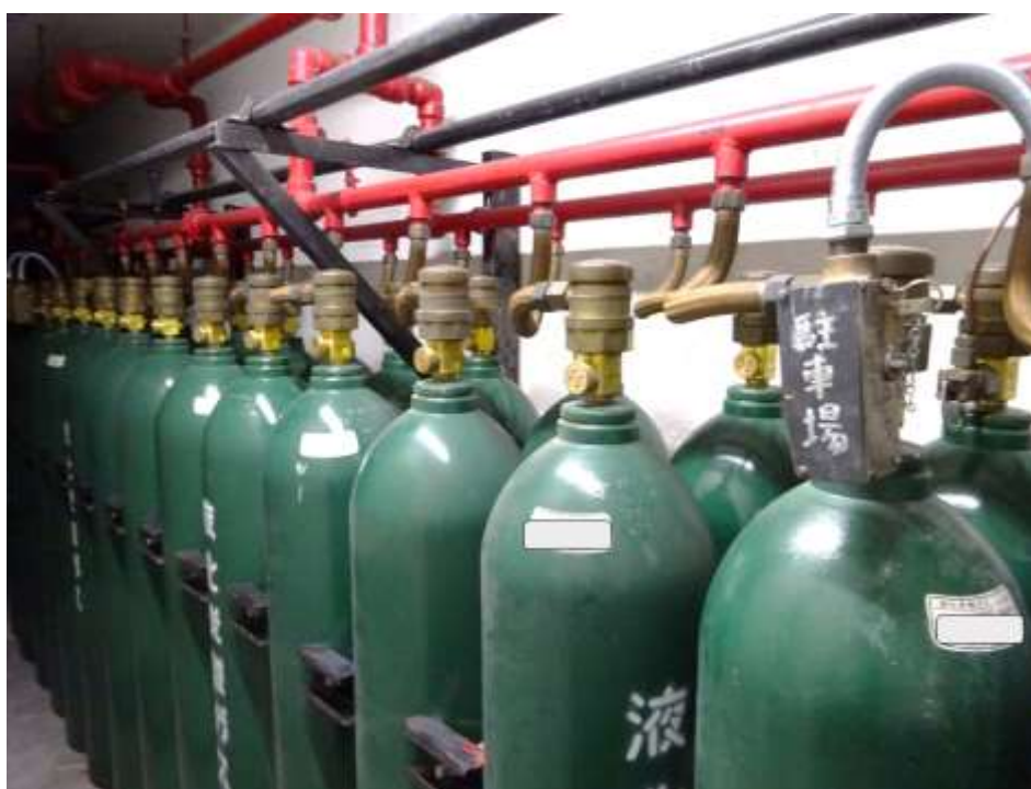
図 4 容器弁(附属品)に設置されたコントロールヘッド(ソレノイド式)
