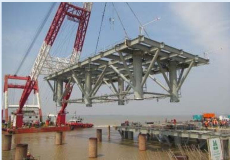
写真：ジャケット工法の据付時の状況
