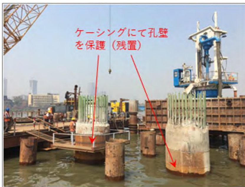
図 9.2 ケーシング存置による海水汚濁防止例
