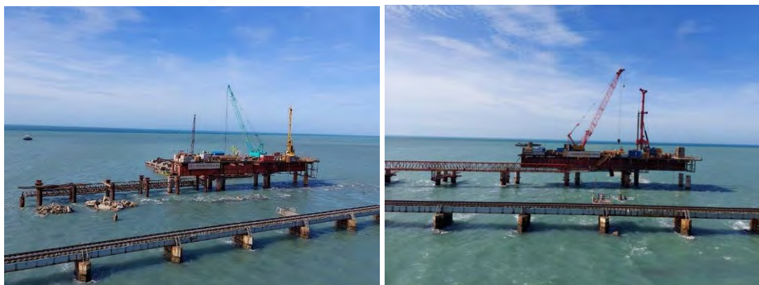
図 4.30 簡易栈橋の工事例（Pamban Bridge – INDIA）
