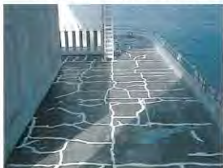
写真-1 施工前のひび割れ部処理状況
