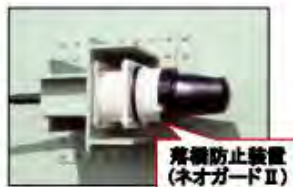
図 4.23 分散支査の防蝕塗装例
