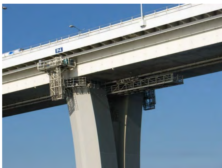
図 4.60 アクアラインにおける移動点検車（側面用及び下面用）
