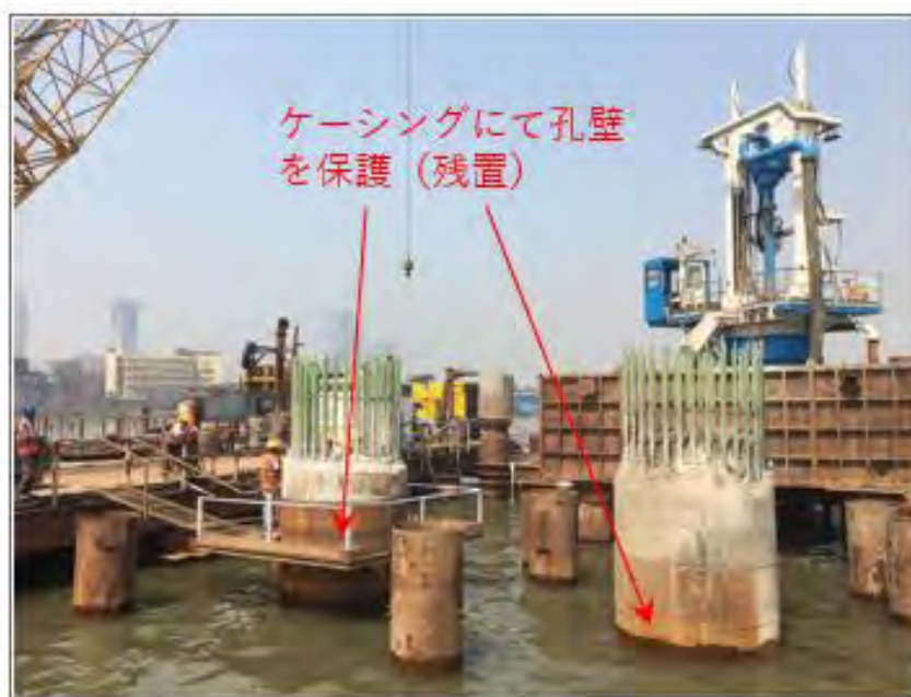
図 4.24 ケーシング存置による海水汚濁防止例
