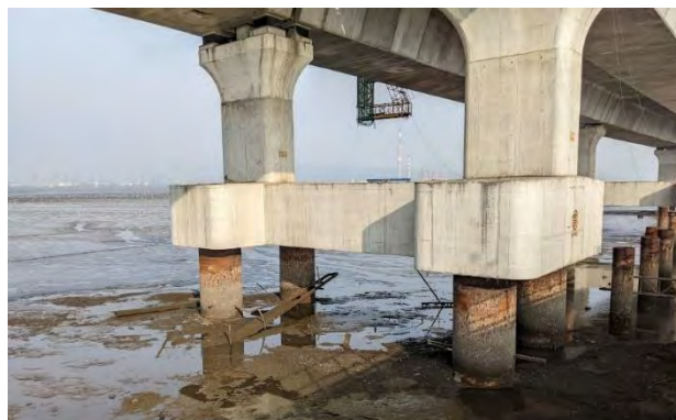
図 4.9 パイルベント形式・参考写真（施工中の MTHL 事業）
