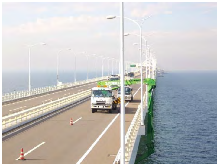
図 4.59 アクアラインにおける橋梁点検状況
