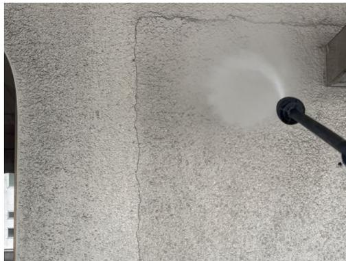
高圧洗浄機による壁面の清掃
