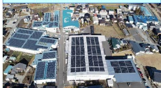
南信精機(日本) 外観写真
