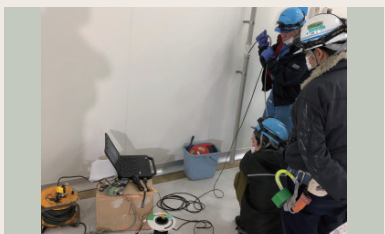
狭い配管も検査可能
