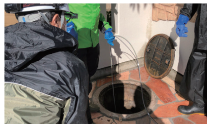
配管調査の様子
