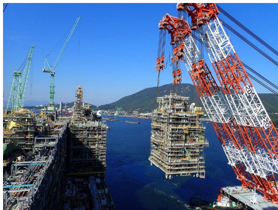
図 4.4.2 FPSO へのモジュール搭載
