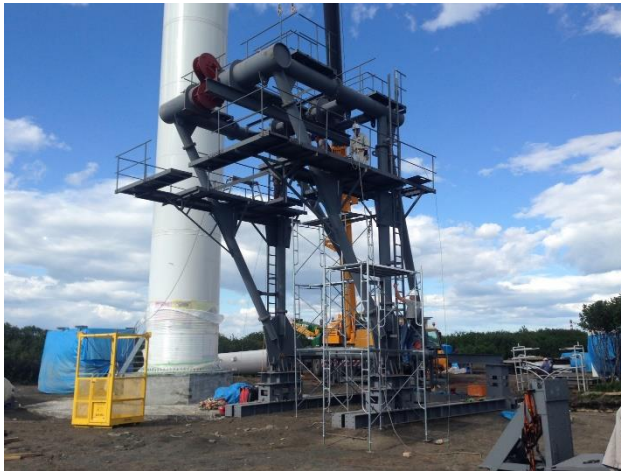
図表 3.4.23 ナセル架設システムによる風車建設の様子
