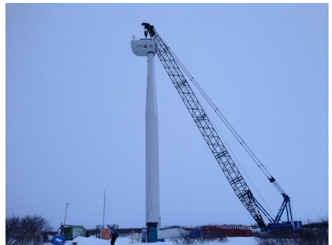
図表 3.4.21 クレーンによる風車建設の様子
