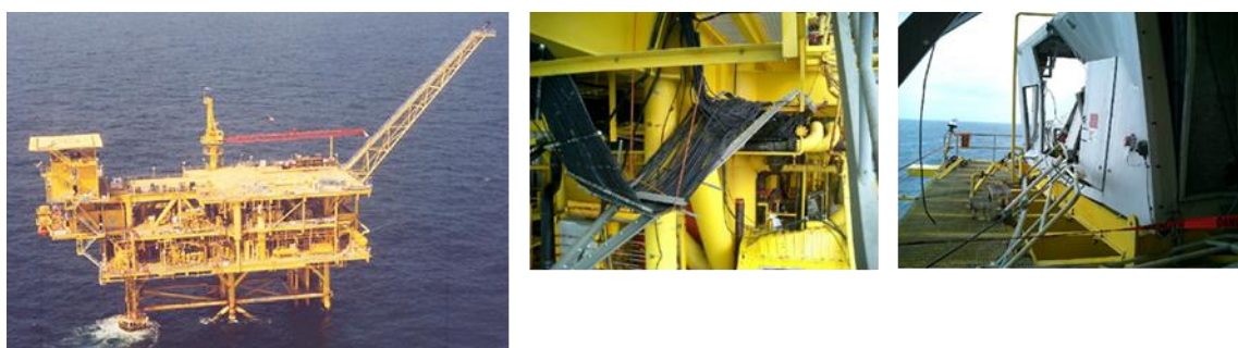
図 3.1-8 原油生産プラットフォーム搭載設備傷害（ケーブルトレイ・パッケージ発電機）
