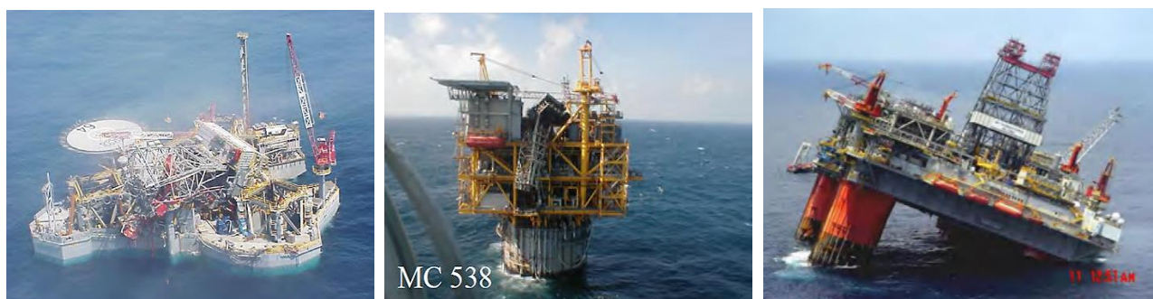
図 3.1-5 被災原油生産・掘削プラットフォーム
