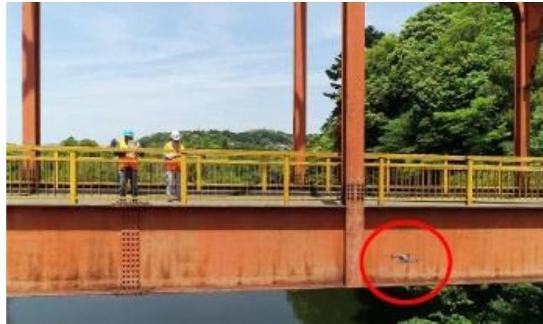
**職員自らがドローンを操縦して橋梁を撮影し、取得した映像から職員が損傷状況を確認・診断する「君津モデル」を確立。**君津モデルによって、外部委託点検でかかっていたコストや点検に要していた時間を大幅に削減する。また、数人の職員が動画での橋梁全体の点検を実施、かつAIと組み合わせることで点検精度も向上。
