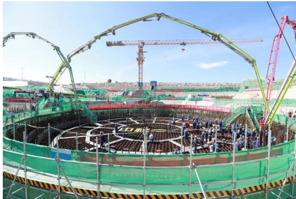
図表2-75 玲龍一号建設作業の様子（海南省昌江）
