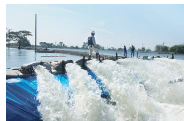
▲国際緊急援助隊による排水作業
