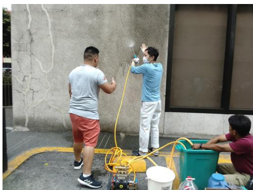
▲エバープロロングを塗布する様子
