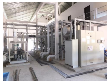
▲高濁度原水対応型浄水装置
