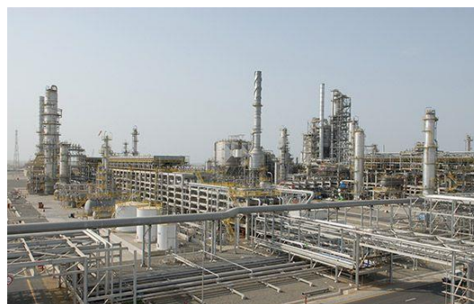
▲オマーンの石油精製プラント
