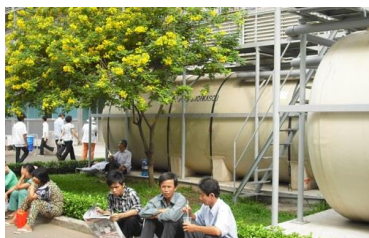
▲病院に設置された浄化槽
