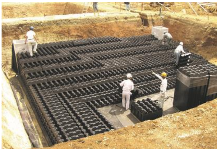
▲クロスウェーブ設置の様子
