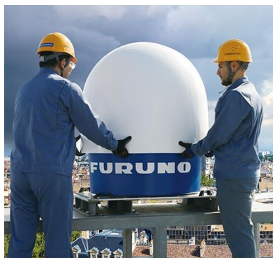
▲人力による設置
