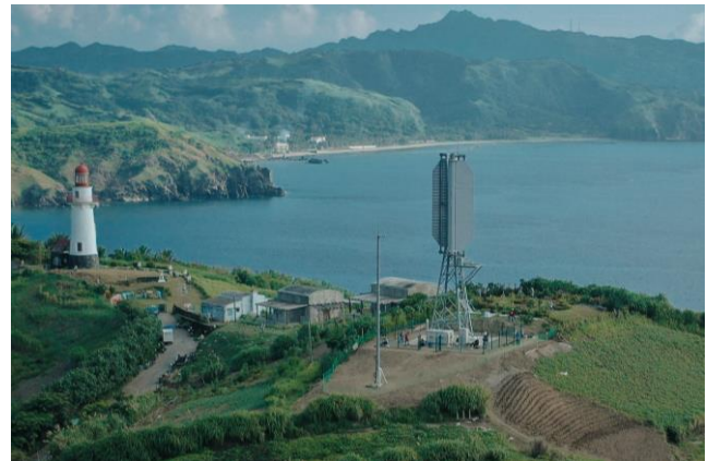
▲垂直軸型マグナス風力発電機 10kW実証機（フィリピンバタン島）
