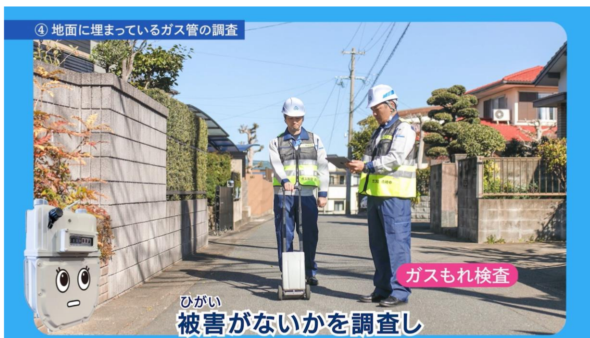
図 5-3 実際の画像等を用いて表現したガス事業者による復旧作業の様子
