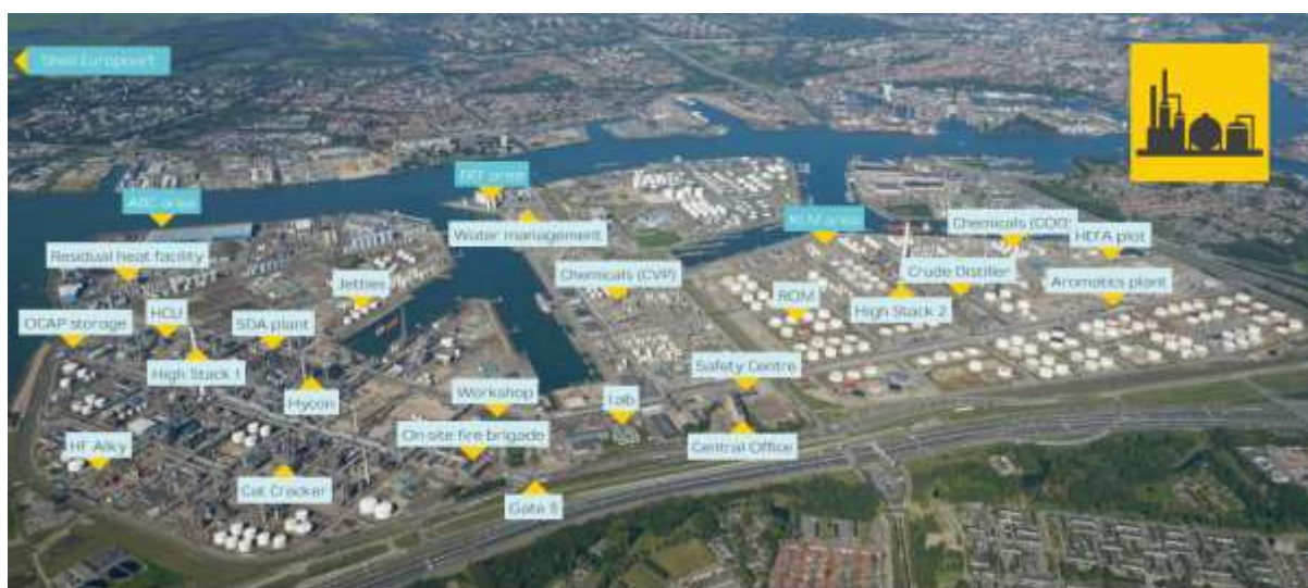
図 2.2.5 Shell ロッテルダム（Pernis）製油所全景（同社 HP）
