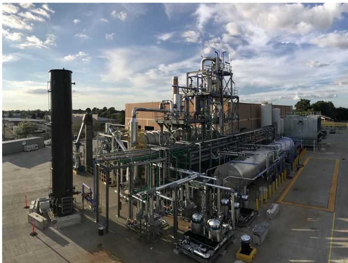
図 4 アクロンにある Alterra Energy の廃プラスチック液化ユニット
