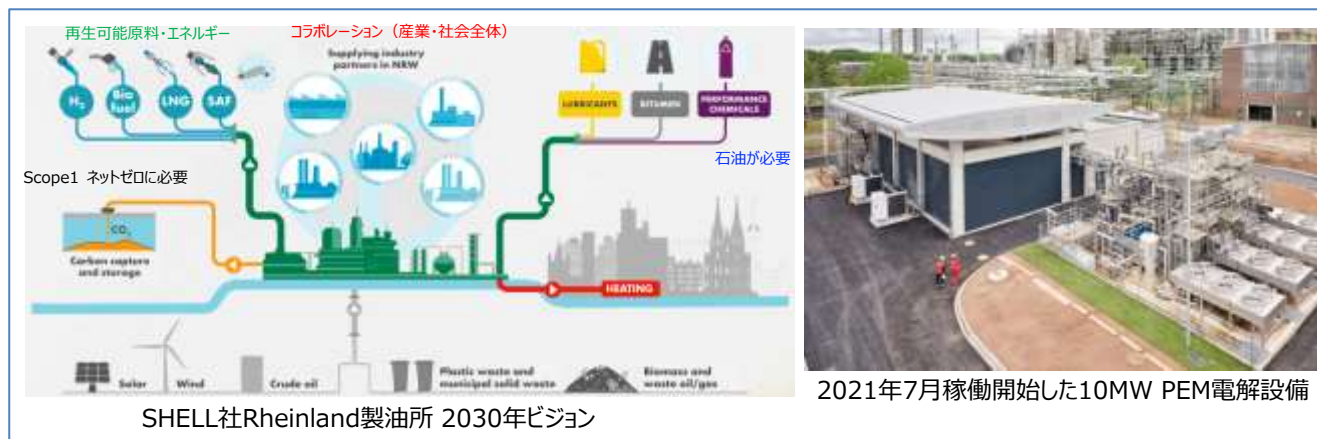
図 2.3.15 Shell 社 Rheinland 製油所の 2030 年ビジョンと設置済み PEM 電解槽（10MW）
