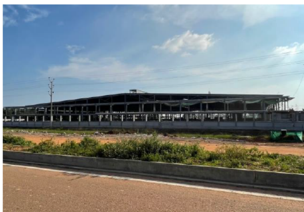
▲建設途中のダイキン工場
