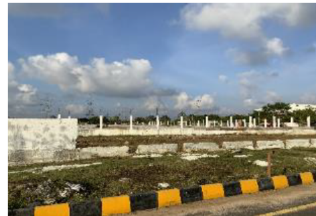
▲Tunge(印)工場建設予定
