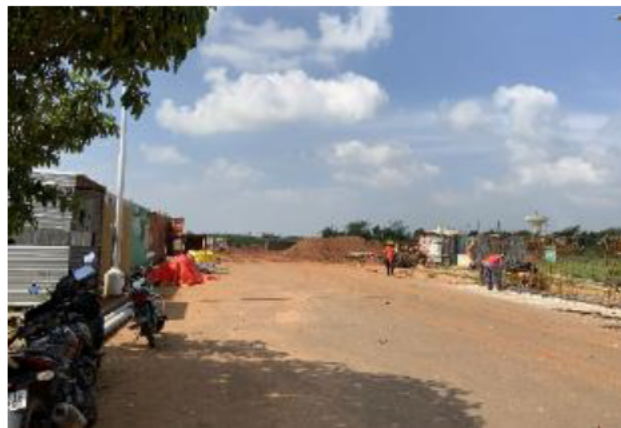
▲第1期区画(道路建設中)
