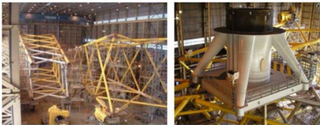
図 6-4 洋上風力における風車基礎部（ジャケット式）の製造 （出典：NEDO(2018)「着床式洋上風力発電導入ガイドブック(最終版)」）
